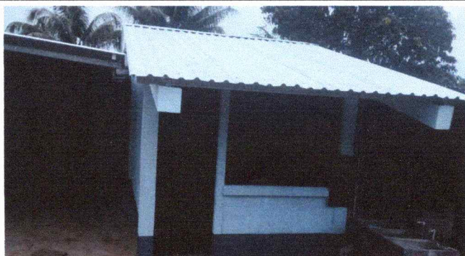
Foto 4: se observa el piso instalado en el corredor de la cocina y instalacion de cubierta de lamina.
