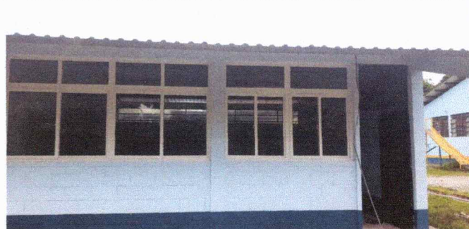
Foto 2: Se observa las ventanas PVC ya instaladas
