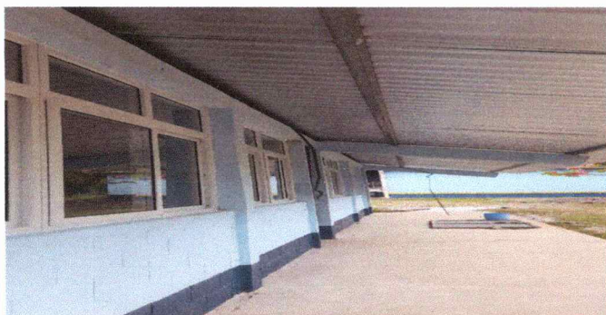
Foto 3: En la imagen se observa ya instalada la cubierta de lamina del corredor
