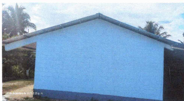
Foto1: Se muestra la finalizacion de pintura de exterior de las dos aulas
